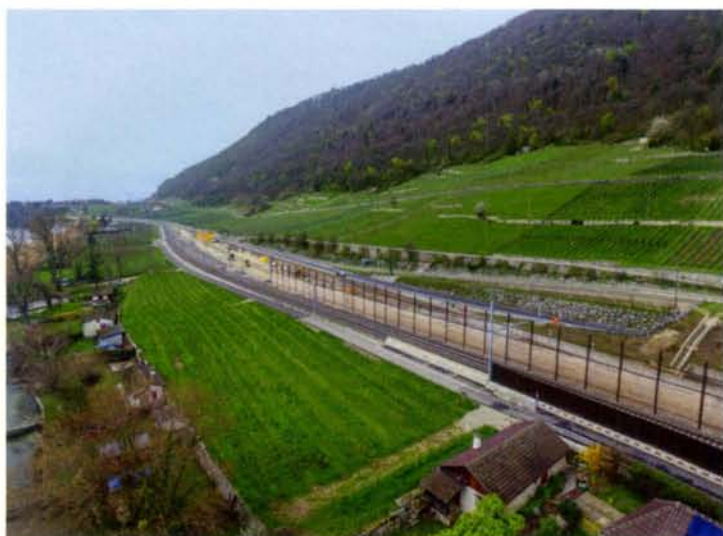
Streckenseitig wurde in einem Bereich die Strecke umgelegt, damit schliesslich der Einfahrtswinkel in den neuen Tunnel stimmt.
