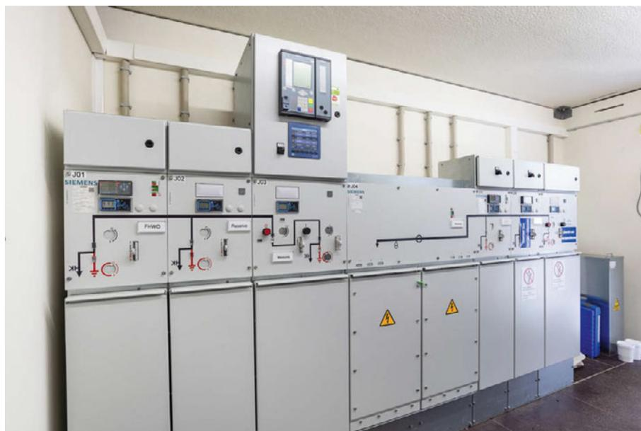
**3:** Im Innern die Leistungsschalter der Mittelspannungsschaltanlage, die das vorgelagerte Mittelspannungsnetz mit den Trafos verbindet
