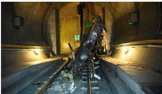
1: Das durchschlagene Spurwechseltor. Nur das Untergestell drang durch das Tor, der Aufbau wurde abrasiert Quelle: SBB
