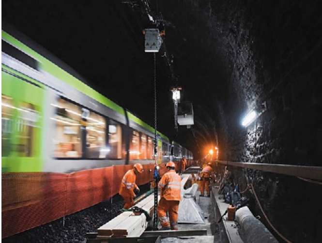
6: Im Lötschberg Scheiteltunnel diente eine am Tunnelgewölbe befestigte Kranbahn für den gesamten Transport von und zur Baustelle Quelle: BLS
