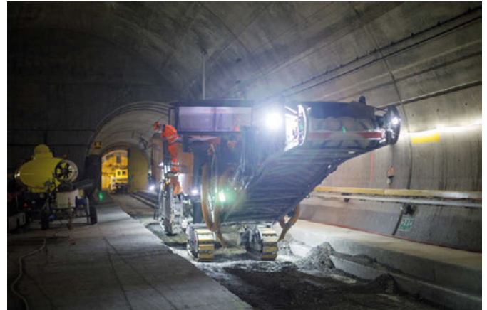
4: Mit dieser Kaltfräse gelang über 7 km die Entfernung der zerstörten Festen Fahrbahn Quelle: SBB
