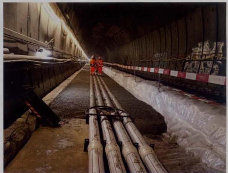
Einbau der Leerrohre für die 132-kV-Kabel und des Fundaments für die feste Fahrbahn des Ostgleises im Wipkingertunnel, März 2024.
