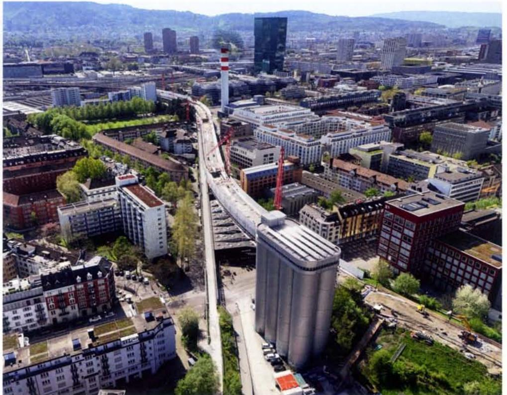
Drohnenaufnahme aus dem Bereich Sihlquai Richtung Süden. Vorne rechts der Damm zwischen der Sihlquaibrücke und dem Auser Sihler Viadukt (neben dem Silo liegt die Rutsche für den Abraum). In der Mitte der Auser Sihler Viadukt mit den Lücken der ausgebauten Stahlbrücken, im Hintergrund links die Vorbahnhofbrücke, in der Mitte die Hardbrücke. Vorne in der Mitte der Lettensteg. Foto: J. D. Lüthard
