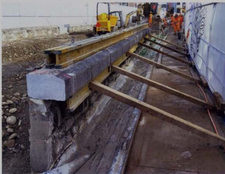
Die Mauerkronenabschlüsse auf dem Aussersihler Viadukt werden sorgfältig instandgesetzt, 21.2.2024.
