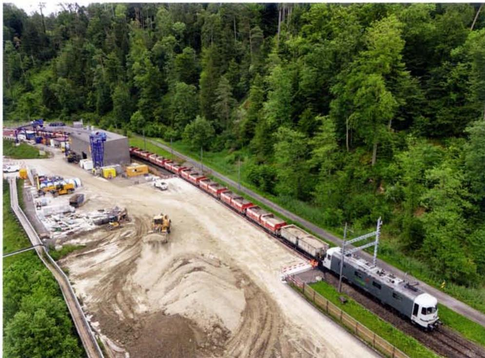
*Drohnenaufnahme des Bauinstallationsplatzes für den Sihlhochwasserentlastungsstollen am 11.6.2024. Für den Verlad des Ausbruchs mit einem Radlader wurde das Kettenwerk der Fahleitung in diesem Bereich zwischen Langnau-Gattikon und Sihlwald entfernt. RADVE-Re 620 003 mit 18 HOLCH-Hubkippwagen: Fans-u 33 85 6770 555-7 (Newag/JMR 1989) und 17 Fans-u 33 85 6770 650–674 (JMR 2001).*
